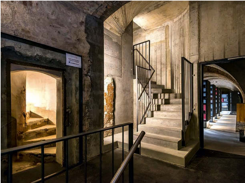
Die Fluchttreppe ist klar als neues Bauteil zu erkennen. • The emergency stair is noticeable as a new element.
